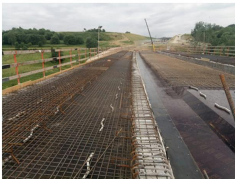
Рис. 1.11. Строительство магистральной железной дороги с применением конструкций безбалластного пути
