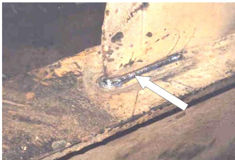
Рисунок 5.2 – Заваренная трещина усталости в сварном шве у окончания кницы на кромке ребра жесткости в конструкции корпуса танкера [86]
